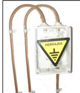
Figura 1.6: Caja de Seccionamiento de Protección
